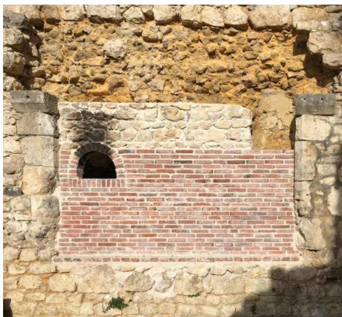
La cheminée XVI e de la salle E du logis seigneurial est en cours de restauration depuis l'été 2018. (© ADVC Brie)
