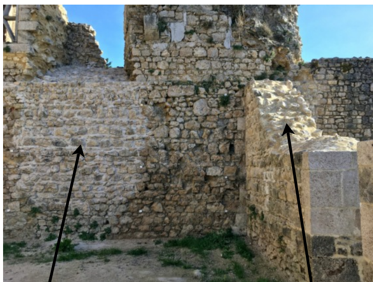
Brèche de la courtine sud-est restaurée en 2018. (© ADVC Brie)
